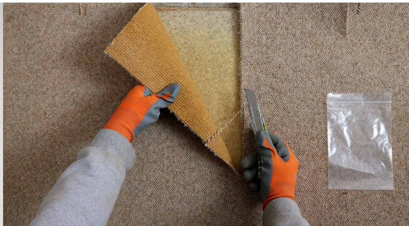
Prélèvement d'échantillons d'un ancien revêtement de sol en matière plastique (p. ex. sous le tapis): pour les revêtements multicouches, enlever toutes les couches, dont fait toujours partie la colle.
